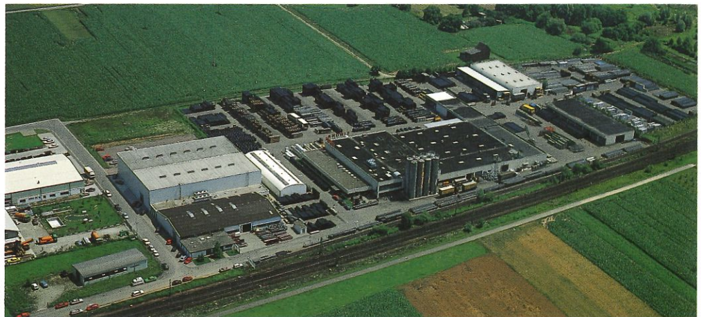
Rohr- und Formteilwerk in Ringsheim
