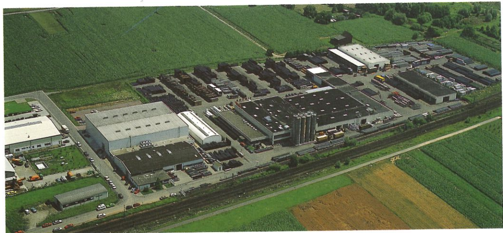
Rohr- und Formteilwerk in Ringsheim
