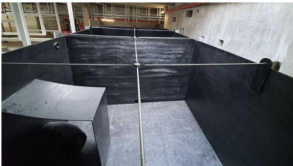
Oben: Fertig montiertes 100 m 3 -Kühlwasserbecken aus kreuzverrippten SIMONA® PE 100 schwarz Hohlkammerplatten; Unten links: Kunststoffbehälter mit einem geschraubten Stahlkorsett aus verzinkten Stahl IPE-Profilen; Unten rechts: Kreuzverrippte SIMONA® PE 100 schwarz Hohlkammerplatte
